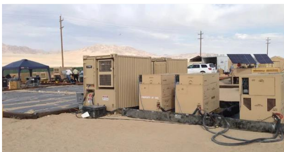
รูปที่ 1 ตัวอย่างสถานีพลังงานสำหรับใช้งานในทางทหาร
